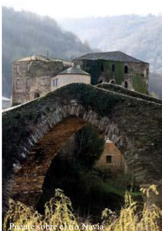
Puente sobre el río Navia
