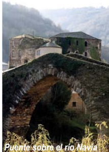
Puente sobre el río Navia
