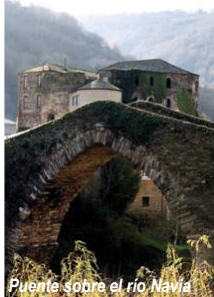
Puente sobre el río Navia
