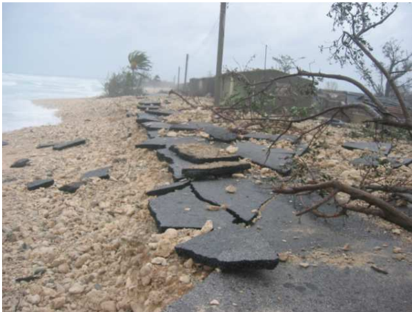
Fig. 7. Efectos del huracán sobre la infraestructura comunitaria en la comunidad de La Bajada
